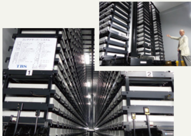
パナソニックアーカイブサービスでファイル化されたLTOテープをはじめ、約60万本のVTRテープが保管されている自動倉庫
